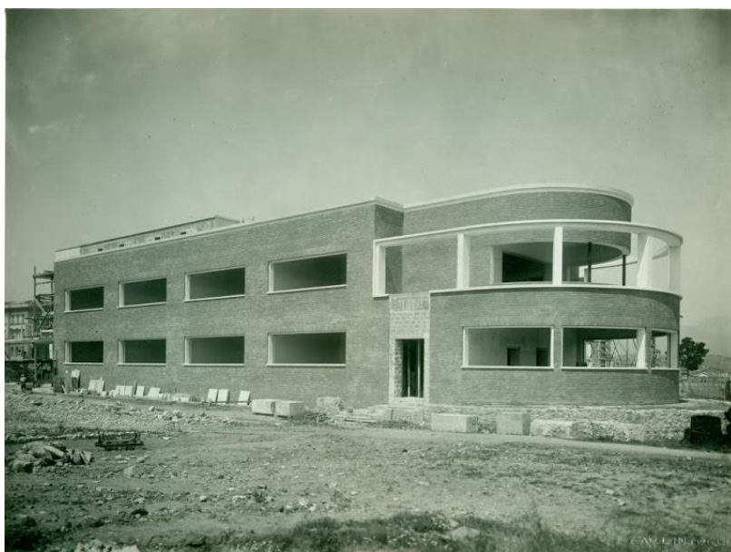
La scuola Mazzini in costruzione negli anni Trenta
